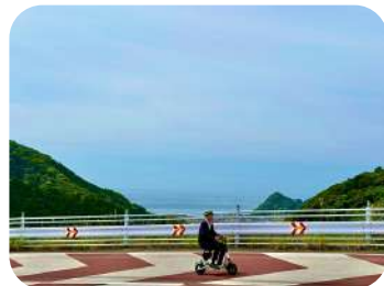
清澄山道ループ橋
